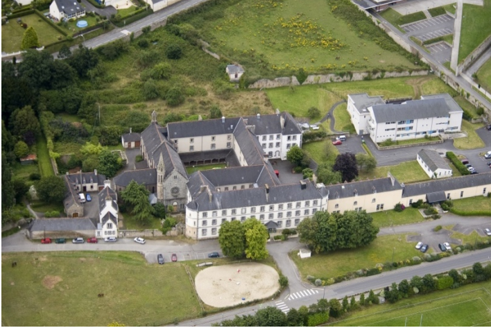
Vue aérienne de Kerlaouen avant la démolition.
